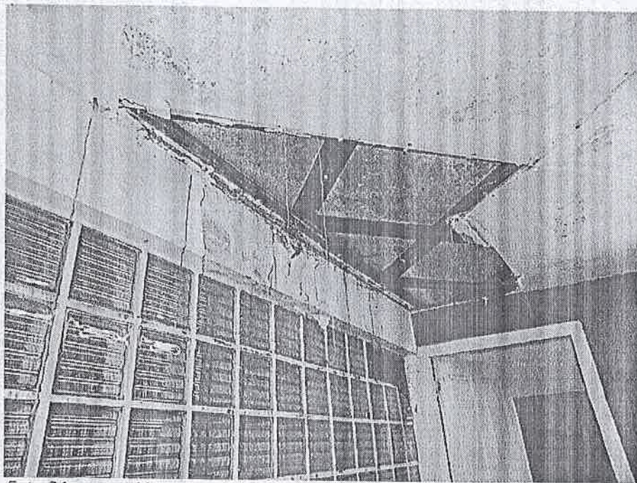
Foto 24 Muur- en plafonddetail
