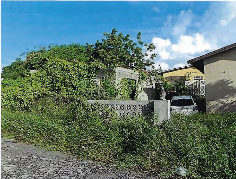
Foto 5 Voor-/zijgezicht in aanbouw zijnde appartement
