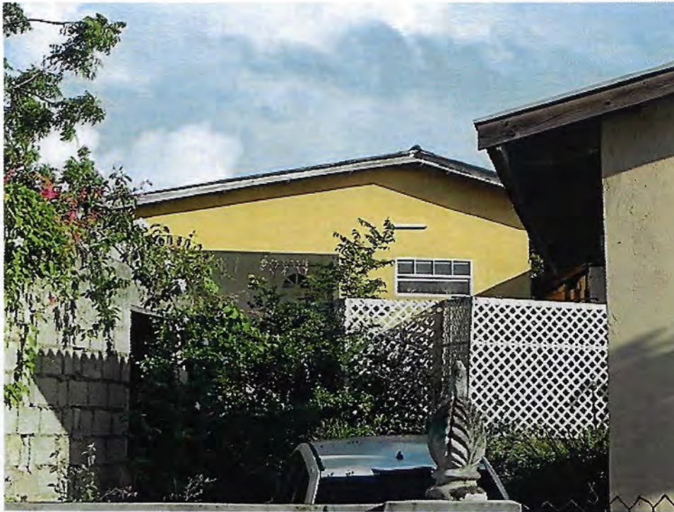
Foto 3 Zicht op zijgevel woonhuis (tussen andere opstallen door)
